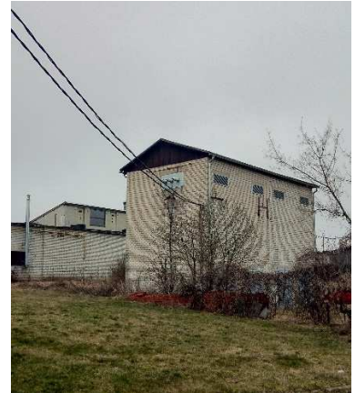
9. attēls. 20/0.4. kV transformatora apakšstacija.
