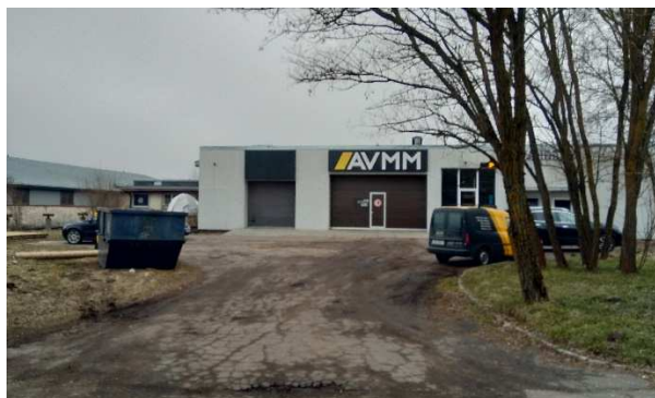
5. attēls. Skats uz kaimiņu zemes vienību ar kadastra apzīmējumu 80700110115.
